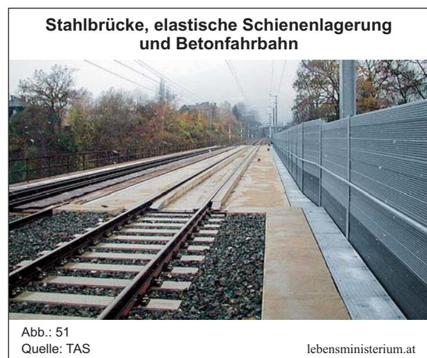
Im Zuge der Sanierung der Wasserparkbrücke in Wien hat sich gezeigt, dass die Verlegung der Auszugsvorrichtung in den Dammbereich die größten Verbesserungen erbrachte.
